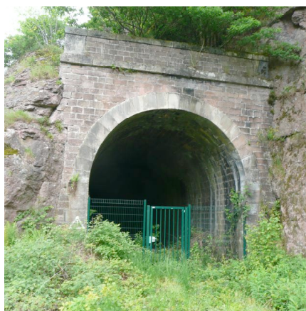
Figure 3 : Le tunnel de Vanémont, PNRBV 2011
