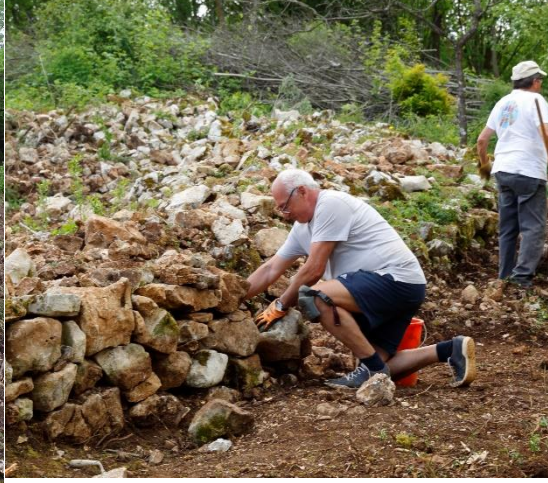
Chantier sous maîtrise d'ouvrage archéologique (avril 2018)
