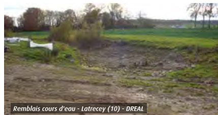
Remblais cours d'eau - Latrency (10) - DREAL
