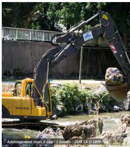
Aménagement cours d'eau - S Gaudin - CRPF CA © CRPF
