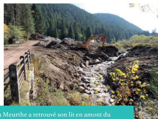
La Meurthe a retrouvé son lit en amont du village du Valtin, grâce à des travaux engagés en 2017
