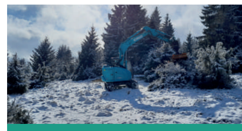
Début des travaux en mars 2025, sous une mince couche de neige...
