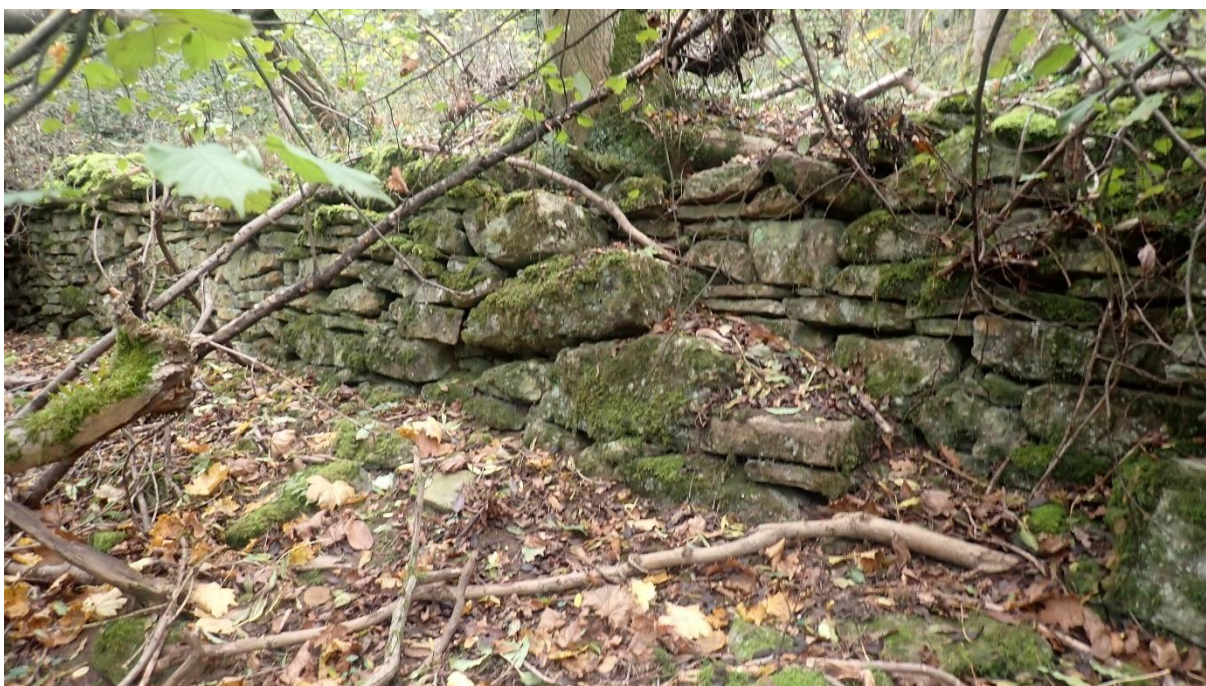
Murets avec escalier recolonisé par la forêt sur le versant Nord du Bollenberg à Westhalten (J-Ch. Dor/CLIMAX, novembre 2022)
